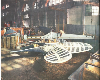
Uno sguardo nello stabilimento Fonderia. Sopra: l'elica di rispetto in bronzo a cinque pale, del peso di 20 tonnellate, destinata alla turbocattorina « Agrigento », in fase di lavorazione preliminare. A sinistra in basso: il modellista Enzo Marini mentre procede al montaggio del modello di un nuovo pompa per motore (Gruppi Diesel/Fiat). - Sotto: i formatori Pietro Gasbardo (a sinistra) e Giulio Testone al lavoro per la produzione di ghisa speciale al ferro eblitico (Fonderia).
